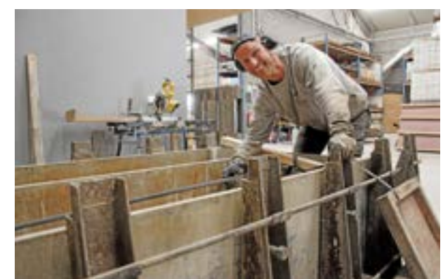
Göran Andersson gör i ordning formar för gjutning av fundament till vägskytalar.
