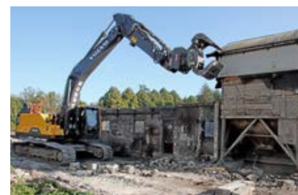
Här rivs de äldsta delarna av betongfabriken för att ge plats åt en ny produktionshall.
